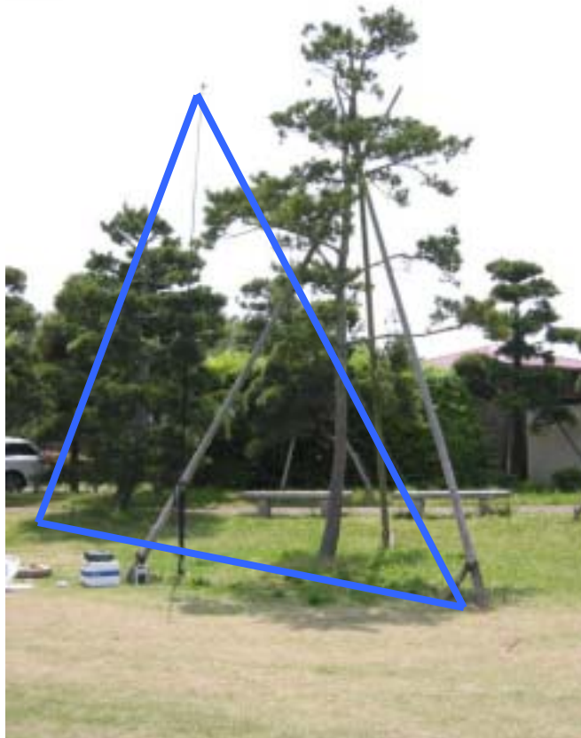
画像 9. アンテナ架設状況 青線がアンテナ・エレメントの形状
